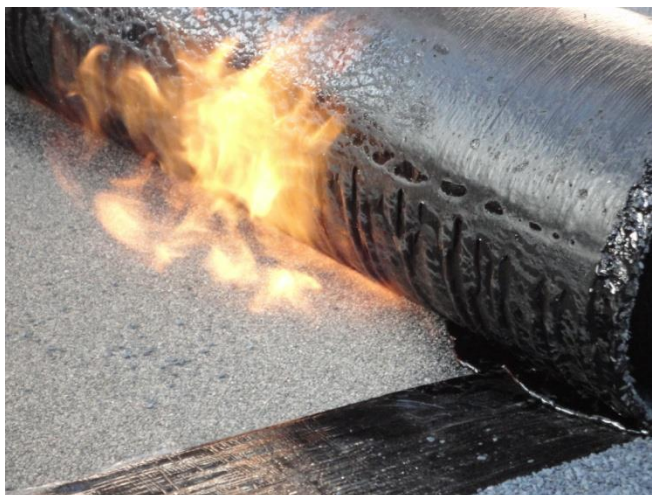
Рисунок 7 – Образование валика битумного вяжущего
