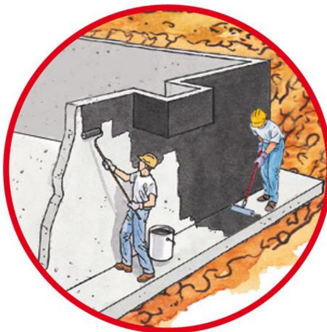
Рисунок 4 – Нанесение праймера на фундамент здания:
