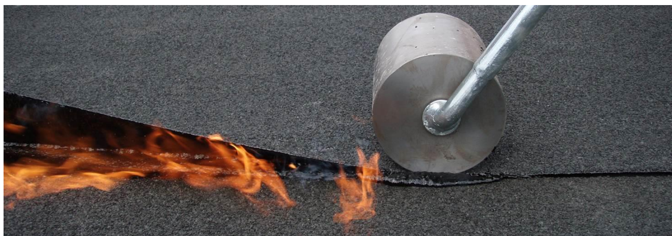
Рисунок 8 – Выдавливание расплавленного битумного вяжущего из-под боковой кромки полотна гидроизоляционного материала
