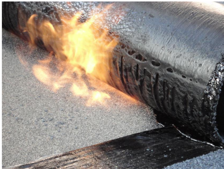
Рисунок 7 – Образование валика битумного вяжущего
