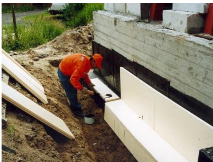
Рисунок 12 – Утепление фундамента плитами экструзионного пенополистирола
