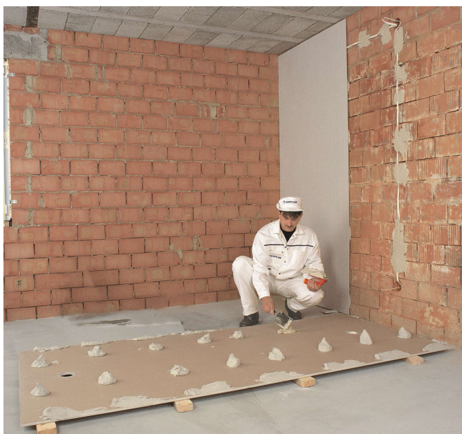
Рисунок 3 – Нанесение клеевого состава на лист
