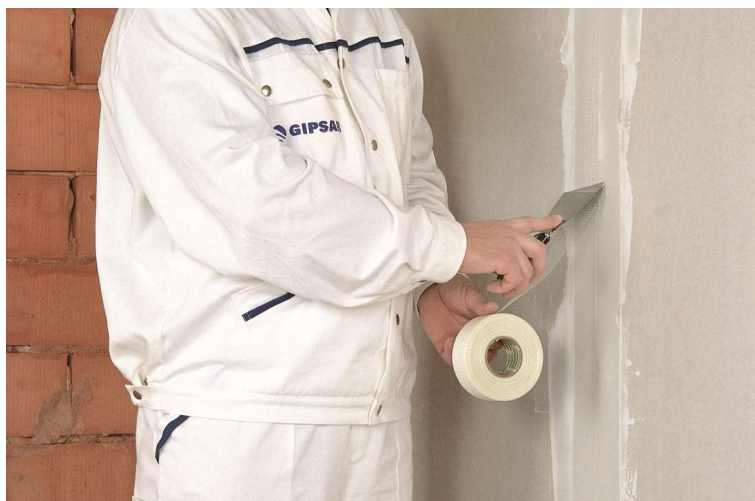
Рисунок 5– Заделка швов
