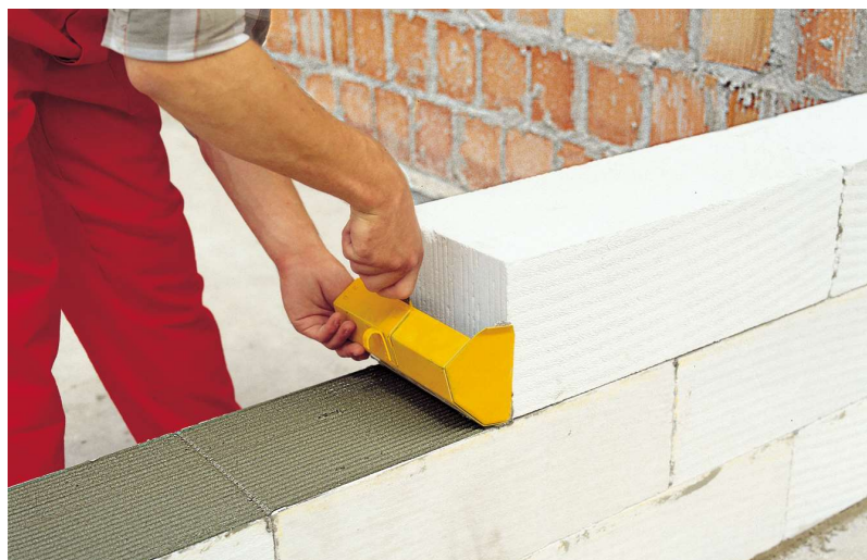
Рисунок 4 – Нанесение клеевого состава на блоки
