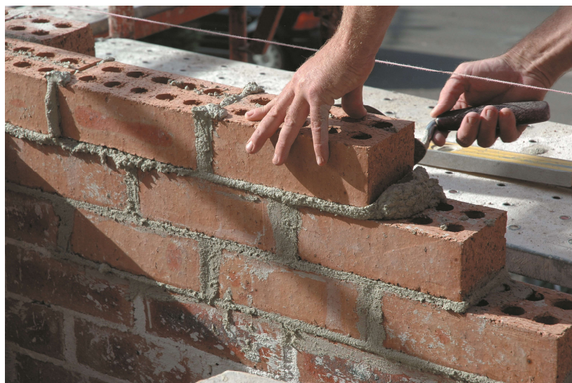
Рисунок 5 – Выполнение кирпичной кладки
