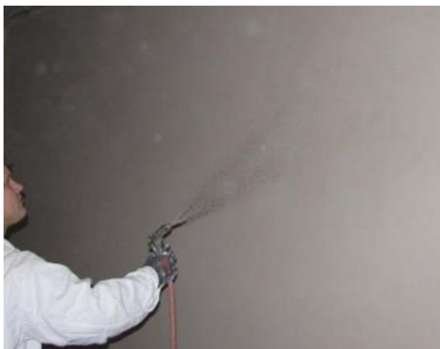
Рисунок 14 – Орошение поверхности водой
