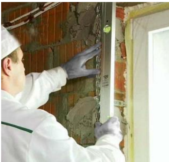
Рисунок 9 – Установка защитного профиля
