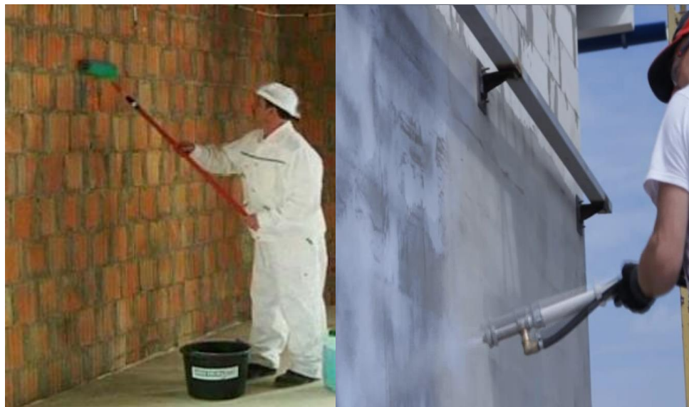
Рисунок 4 – Грунтование поверхности основания
