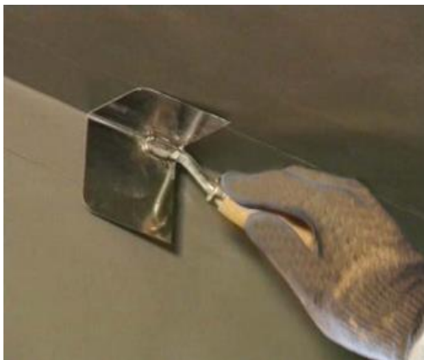
Рисунок 13 – Выравнивание внутренних углов
