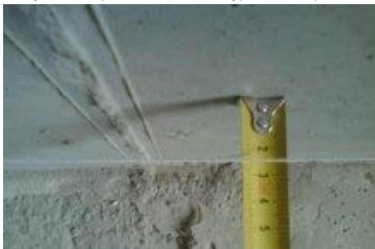
Рисунок 7 – Измерение величины отклонения
