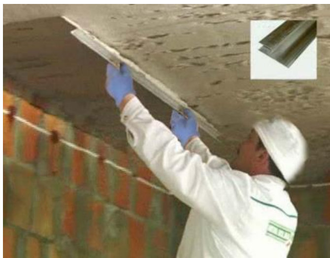
Рисунок 16 – Предварительное выравнивание поверхности потолка
