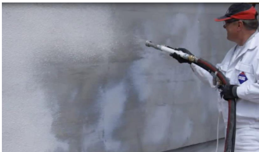
Рисунок 18 – Нанесение защитно-отделочного штукатурного состава
