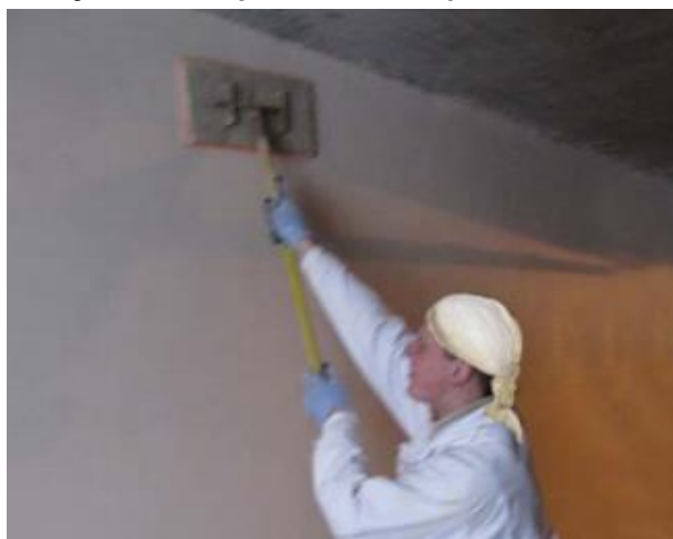
Рисунок 15 – Затирка поверхности теркой с губкой
