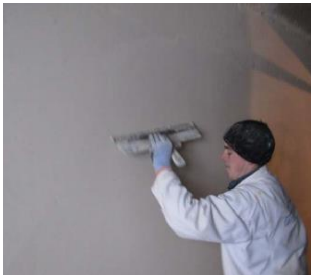
Рисунок 12 – Окончательное выравнивание поверхности шпателем
