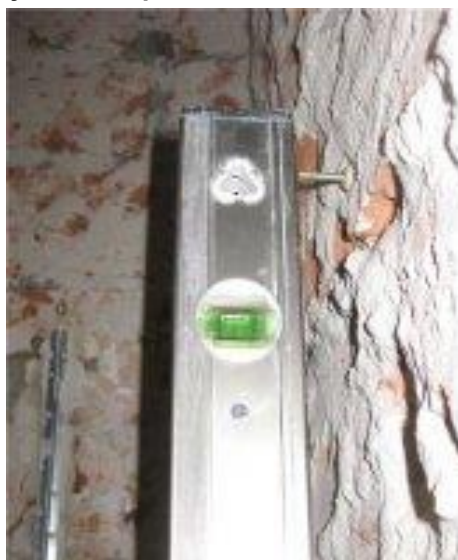
Рисунок 6 – Провешивание стен уровнем с правилом
