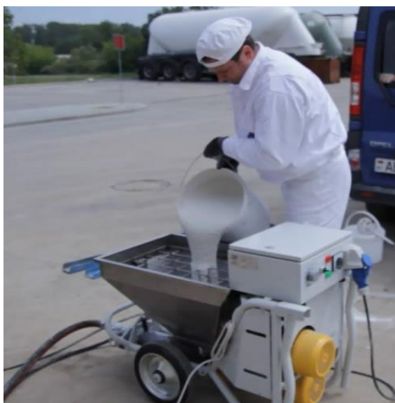
Рисунок 17 - Заполнение бункера штукатурного агрегата
