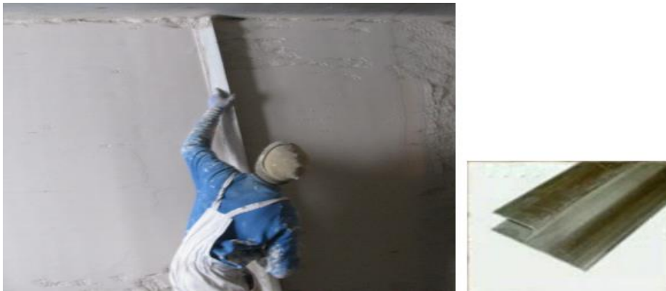
Рисунок 11 – Предварительное выравнивание «h»-образной рейкой
