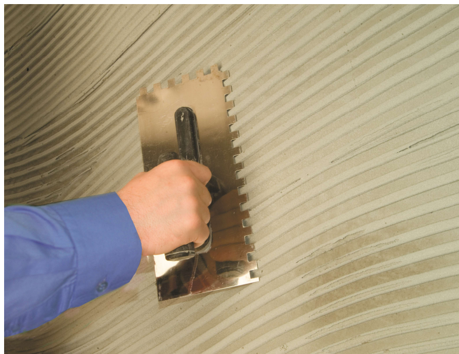
Рисунок 1 – Нанесение состава на поверхность стены
