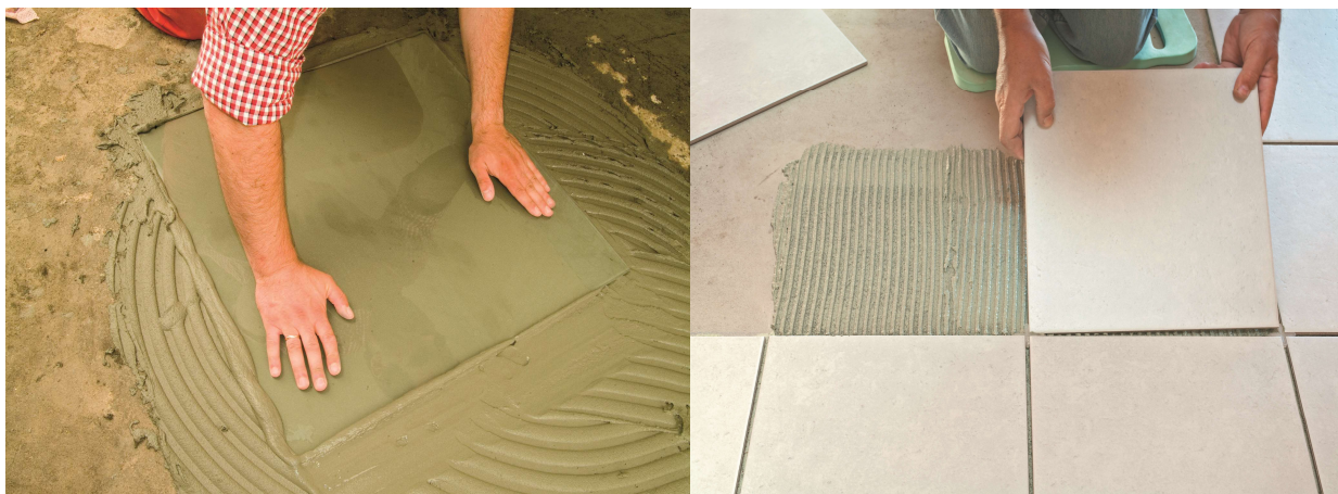
Рисунок 2 – Укладка плитки на клеевой состав
