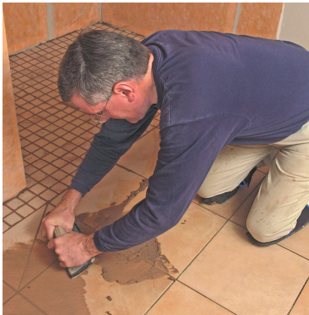
Рисунок 3 – Заполнение швов
