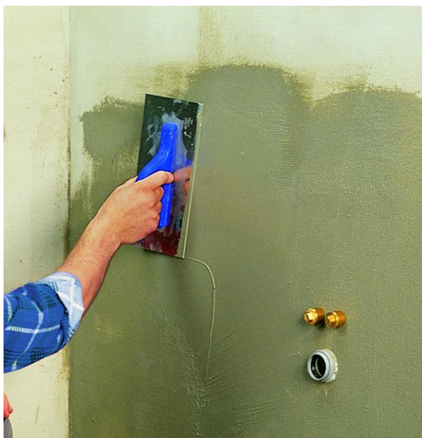
Рисунок 1 – Нанесение гидроизоляционного состава
