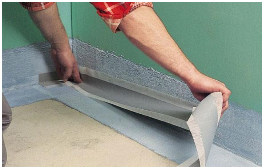
Рисунок 2 – Устройство гидроизоляции стыков
